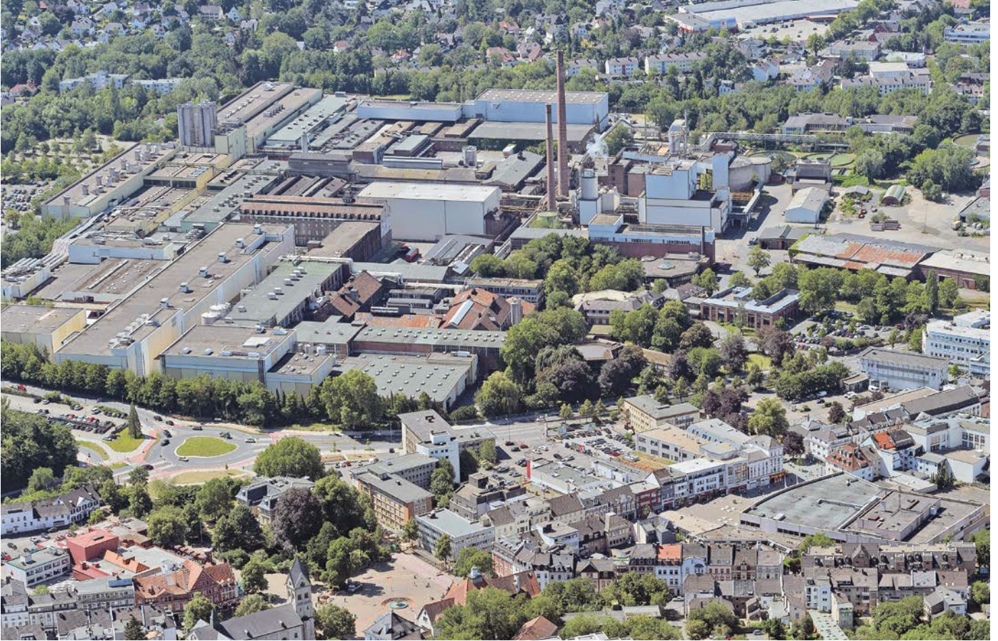
Das 37 ha große Zanders-Areal liegt zentral in Bergisch Gladbach.
