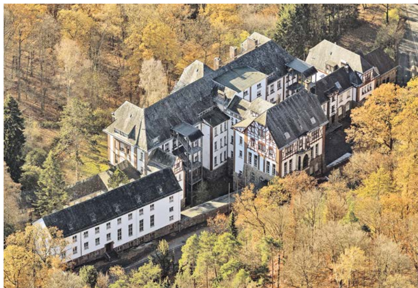
Das Waldkrankenhaus steht seit 15 Jahren leer. Es wird zeitweise als Filmkulisse genutzt.
