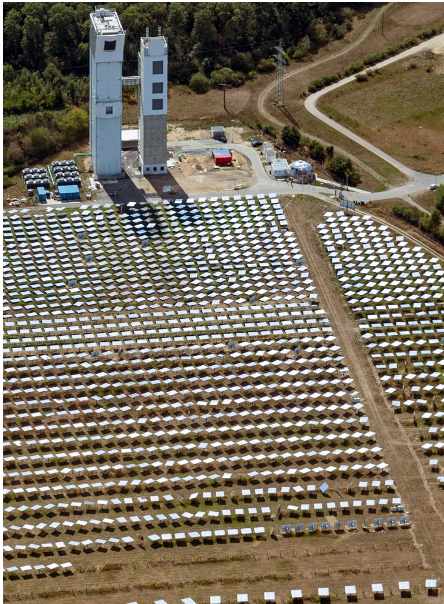
Solarturm / DLR Jülich
